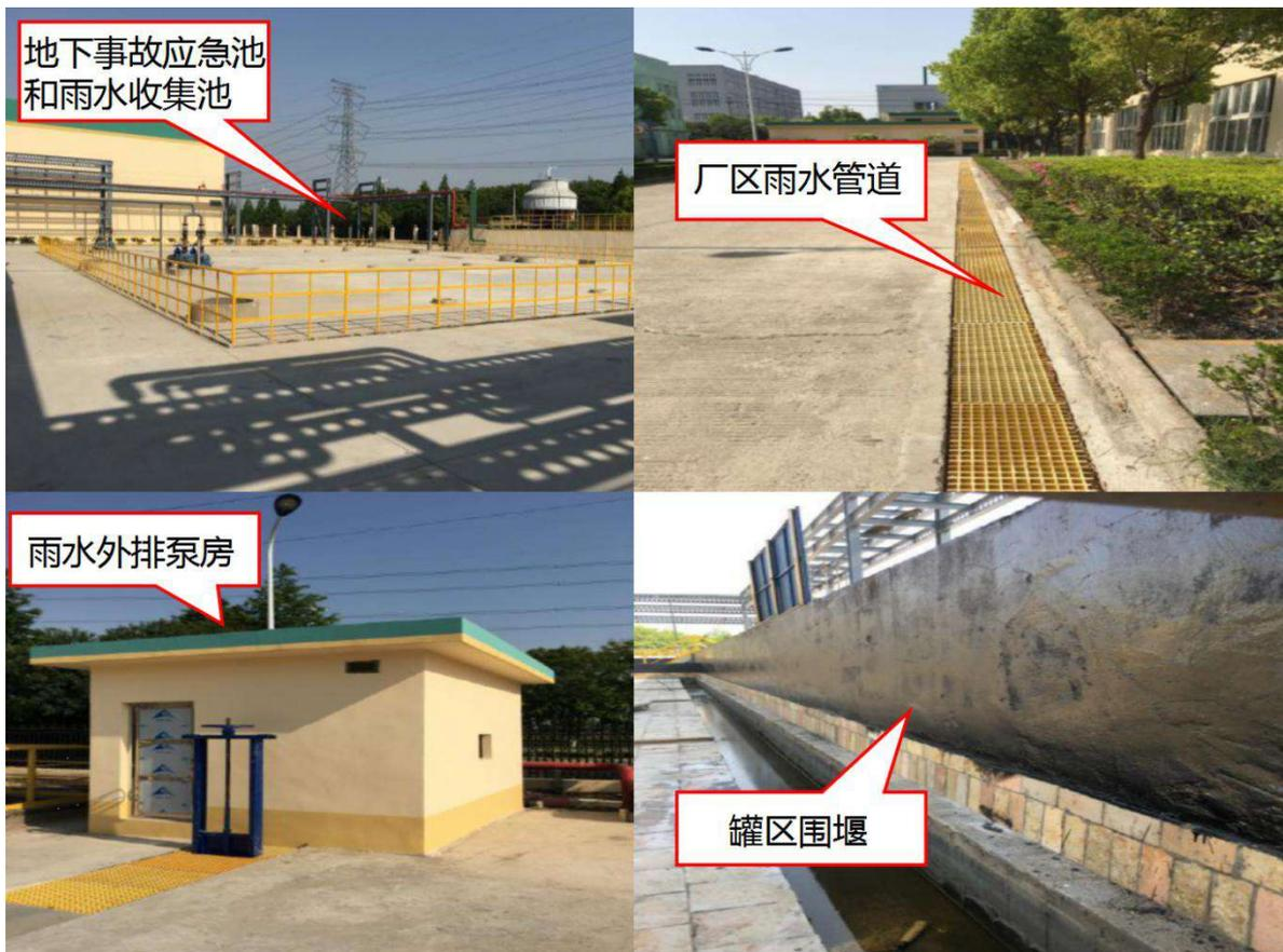
图 4-5 事故应急池、雨水管道和罐区围堰
