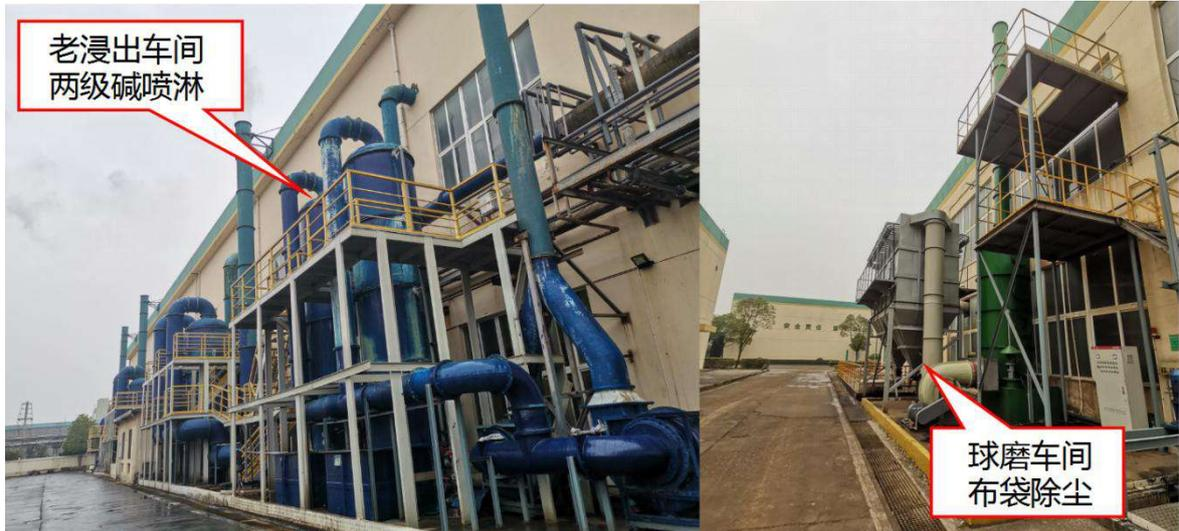
图 4-3 废气处理装置
